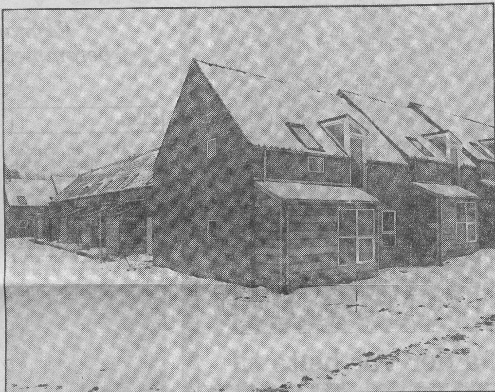
Som små knaster skyder stueudbygningen frem fra huset. Markant anderledes med ydervæggen dækket af eternit. De forskudte højder samt de karakteristiske kviste giver bebyggelsen stor variation.
